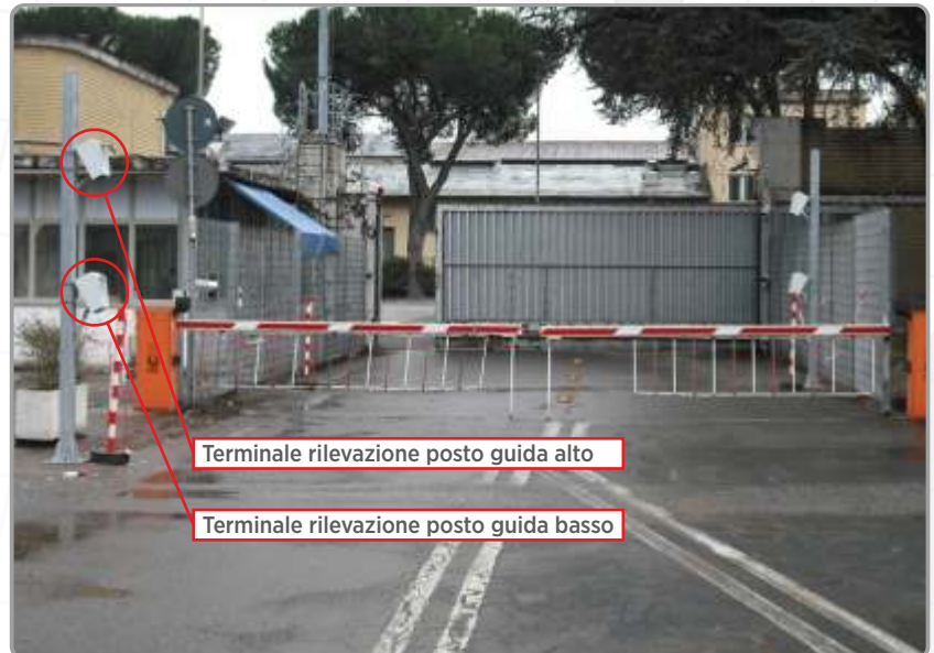
Varco di accesso: terminali di rilevazione
